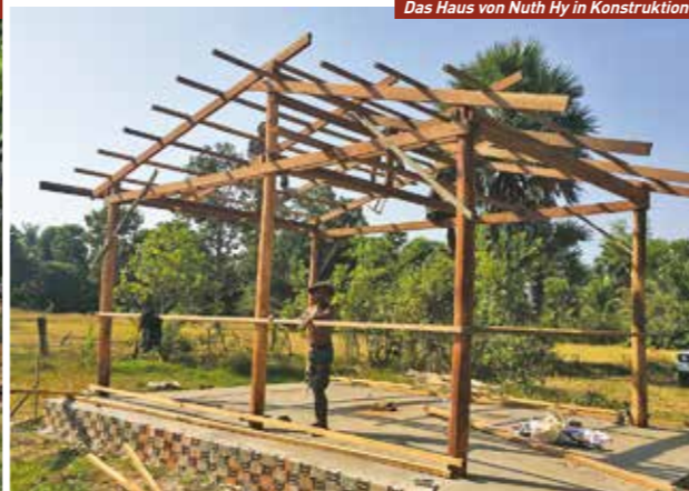
Das Haus von Nuth Hy in Konstruktion
