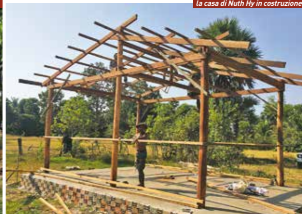
la casa di Nuth Hy in costruzione
