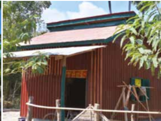
Das Haus wird gebaut
