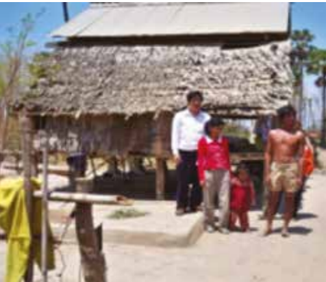
Das Haus vorher
